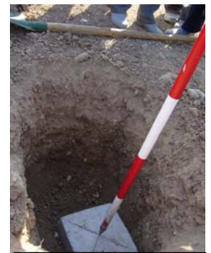
Der verlorene Hauptmeßpunkt wird neu gesetzt.
