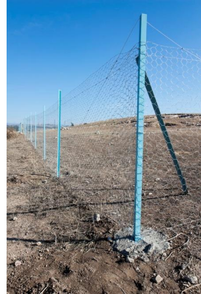
Res. 38: Kazı alanı güçlü bir telden korunuyor / Stabiler Zaun mit einbetonierten Pfosten umschließt das Ausgrabungsgelände
