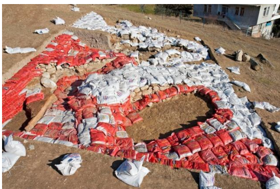
Res. 40: Açma 7785-86'daki şehir kapı kulesi kum çuvalar ve jeotextil ile korunur / Schutz des Turmes in 7785 mit Sandsäcken und Jeotextil
