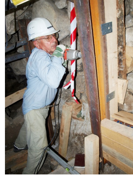
Res. 09-10: Tünelin sağlamlaştırması çelik ve ahşap malzemeleri (Mühendis Dr. Günther Brem)
