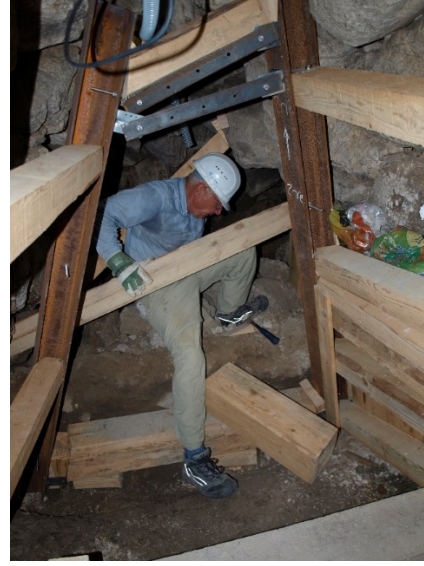
Res. 09-10: Tünelin sağlamlaştırması çelik ve ahşap malzemeleri (Mühendis Dr. Günther Brem)
